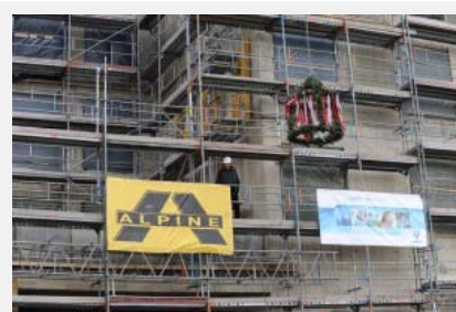
Polier Holger Simon sprach den Richtspruch auf den Neubau
